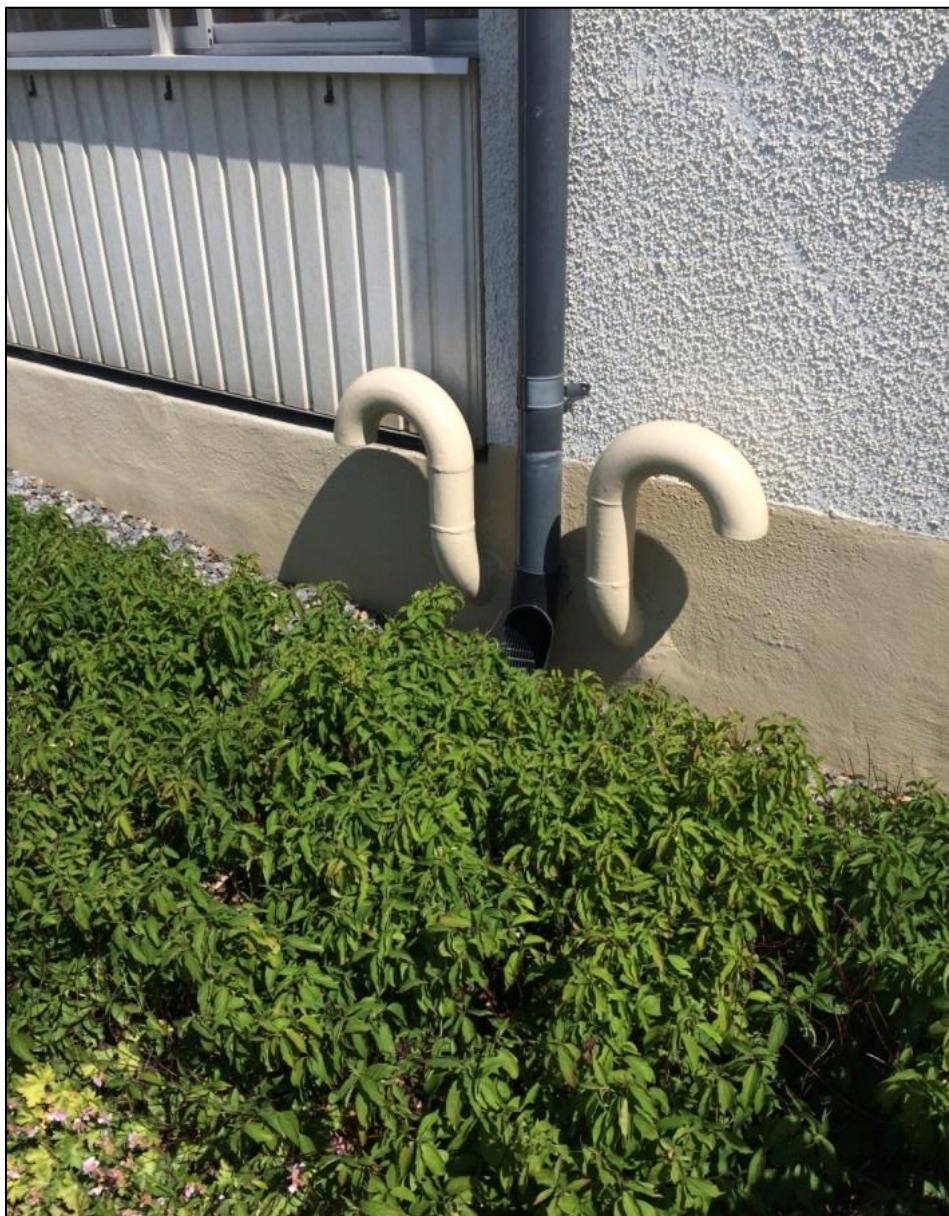
Figur 6-12. Fotot visar hur dagvatten leds ner från taken via stuprör till en växtbädd i ett område i Östberga. Detta är ett exempel på hur dagvatten kan fungera som en lokal bevattningsskälla (foto: Frida Hammar).
