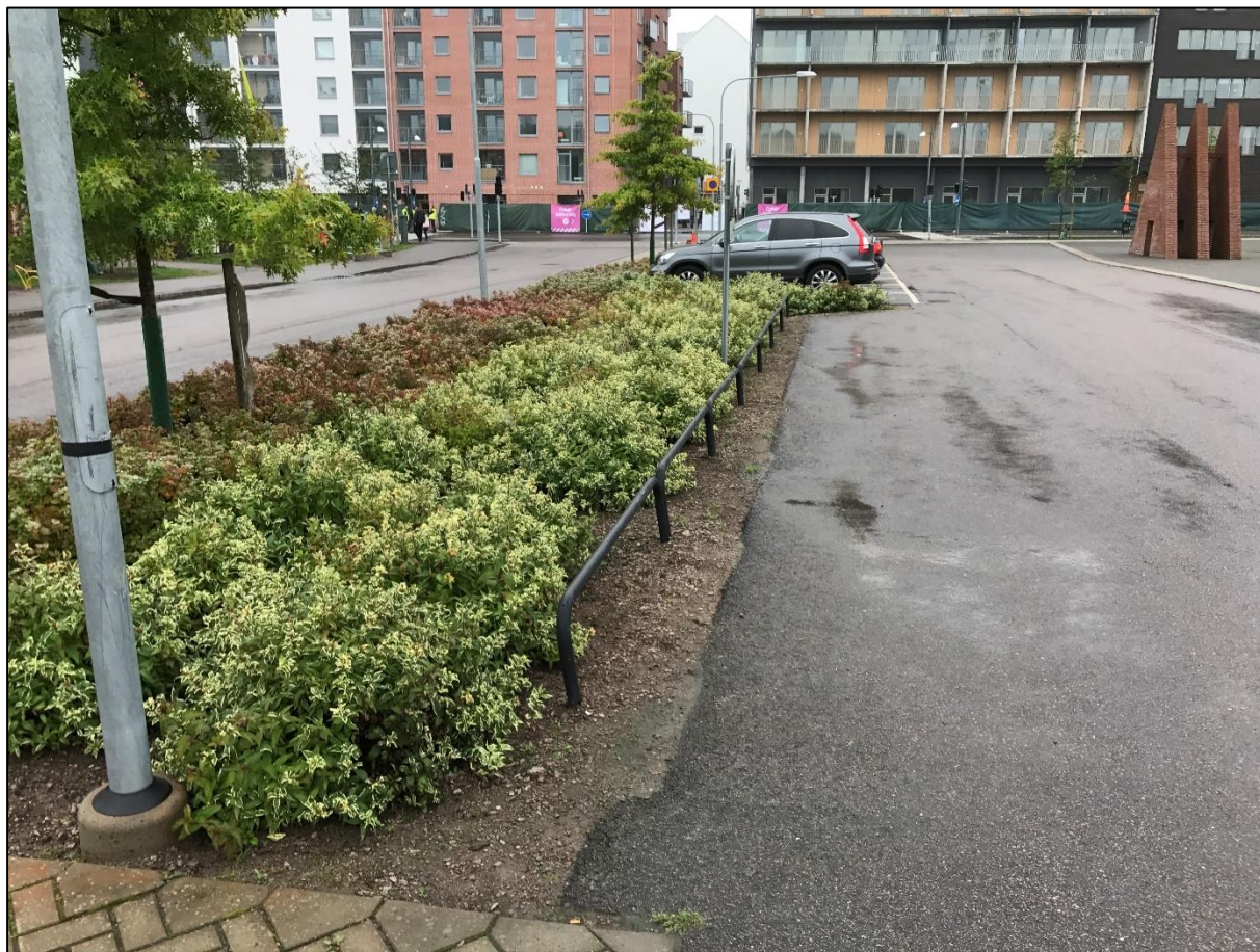
Figur 6-13. Dagvatten från väg och parkeringsytorna kan med hjälp av självfall och utan hinder i form av kantsten transporteras till intilliggande odlingar.
